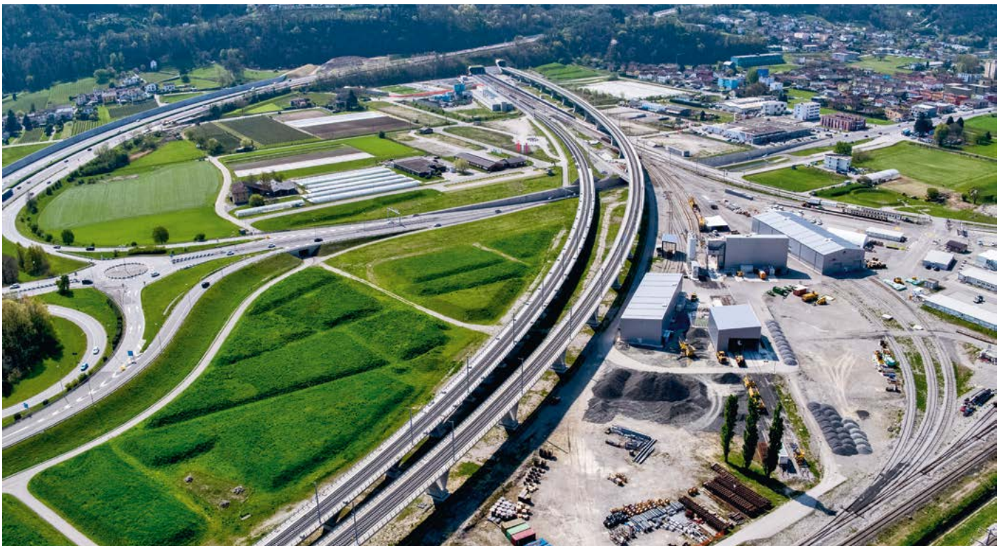
Unsere Bahninfrastruktur setzt auf viele Brücken und Tunnelbauten, die hohe Ansprüche an Kosten, Umwelt und Freiräume erfüllen müssen. Im Bild die Zufahrt zum Ceneri-Basistunnel mit dessen Nordportal. (Foto: AlpTransit Gotthard AG)
