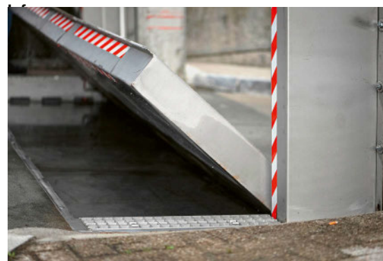
Ein automatischer Klappschott schützt Zugänge vor Hochwasser.
