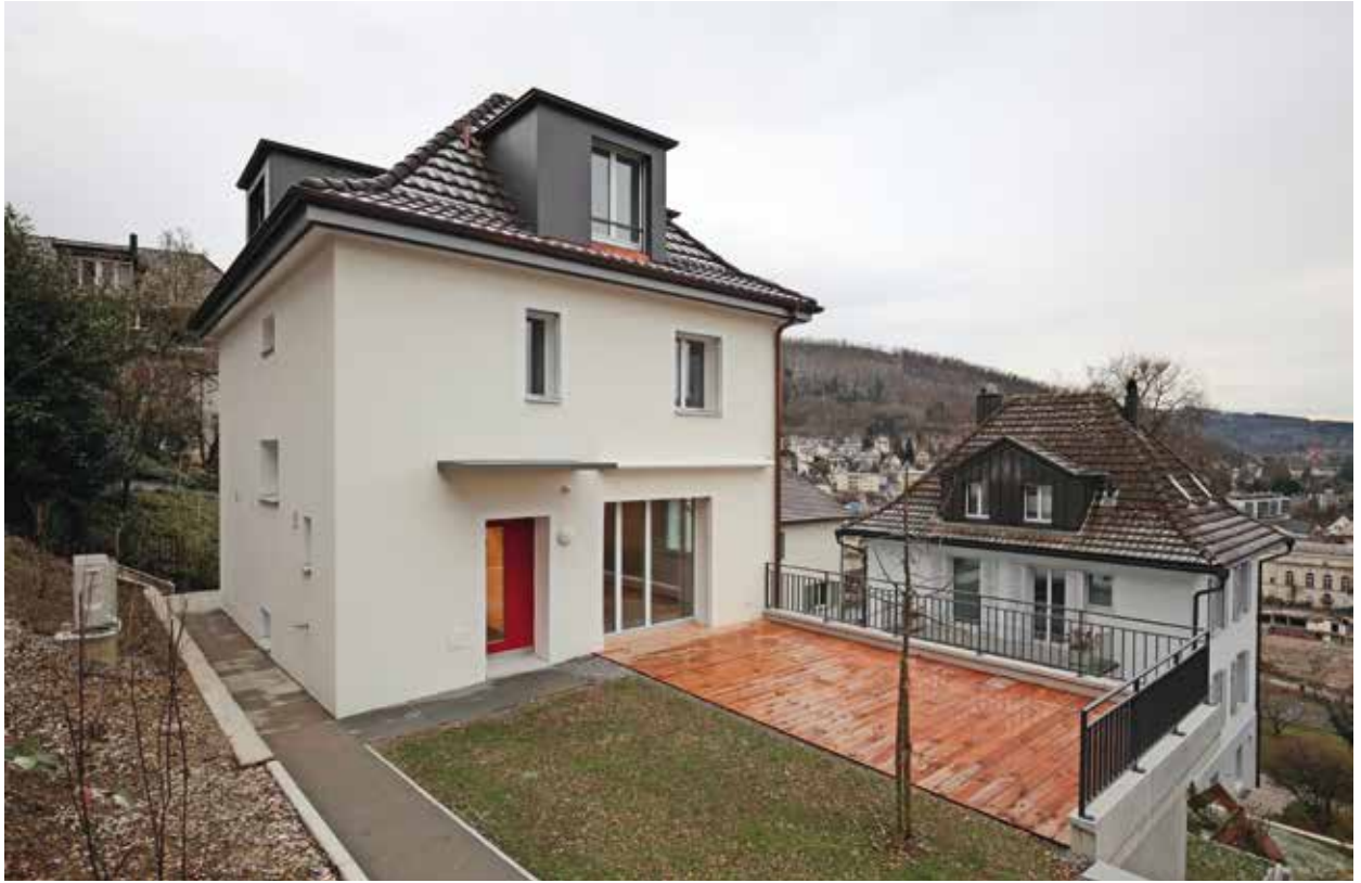
Im Dezember 2017 konnte das erste Minergie-Zertifikat «Systemerneuerung» an dieses Gebäude in Ennetbaden, AG, vergeben werden.
