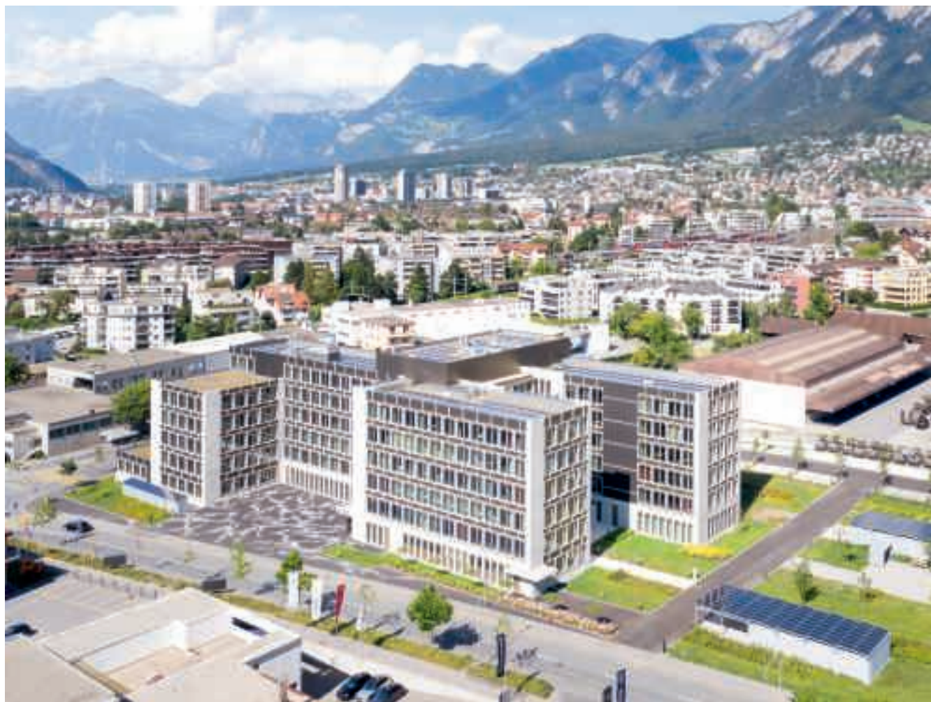
Der von den Photovoltaikanlagen auf den Dächern produzierte Solarstrom trägt zum nachhaltigen Betrieb des Verwaltungsgebäudes bei. Foto: Ingo Rasp / Chur
