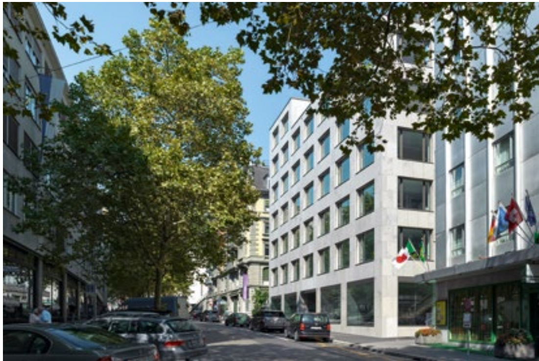
Der Neubau an der Stampfenbachstrasse 30 in Zürich nutzt das vorher von einem bürgerlichen Doppelwohnhaus von 1882 besetzte Grundstück deutlich besser aus und ist das erste Minergie-P-Eco-Gebäude des Kantons.
