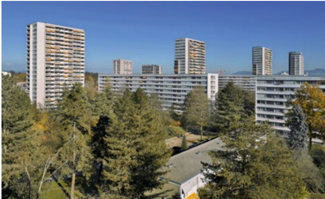
Die Siedlung Tscharnergut im Westen von Bern soll etappenweise so saniert werden, dass sie weiterhin günstigen Wohnraum anbieten kann. An einem der Gebäude wird das Vorgehen exemplarisch erprobt.
