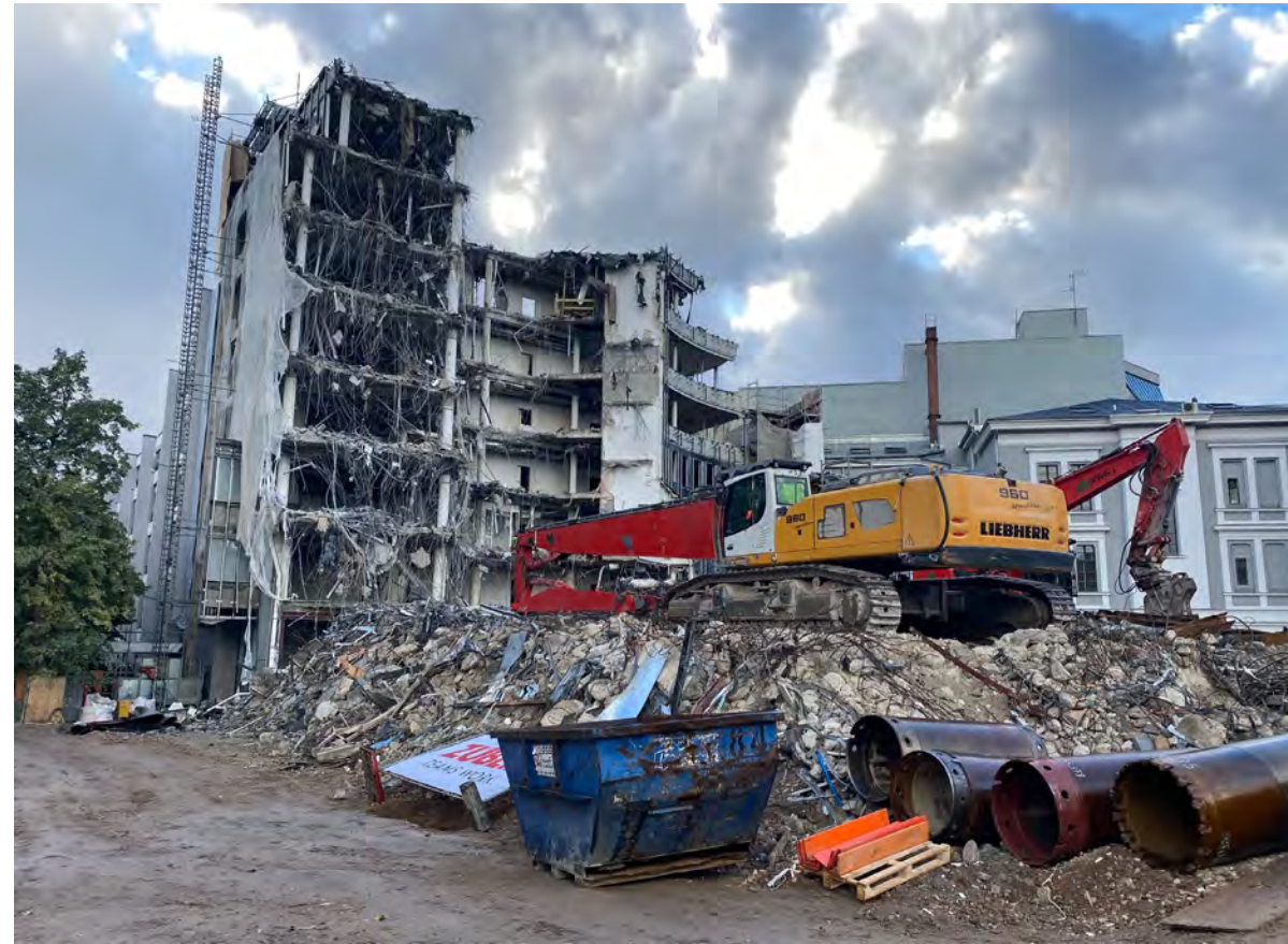
Abbruch Bürogebäude aus ca. 1980 in Berlin
