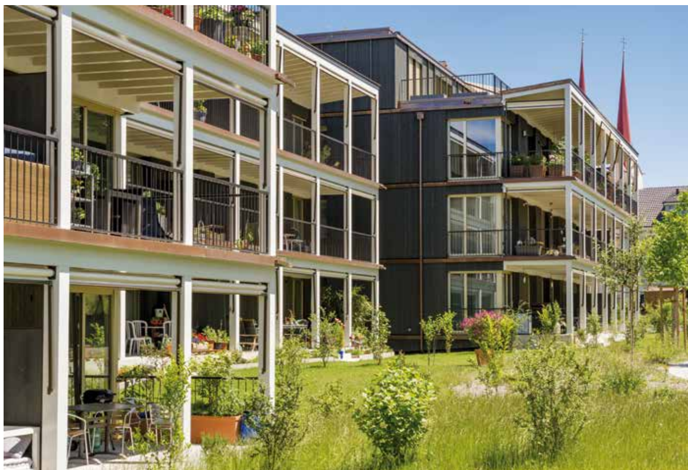
Lotissement Chatzebach, Muri AG, certifié SNBS Bâtiment en 2020. (Photo: simonhuwiler.com)
