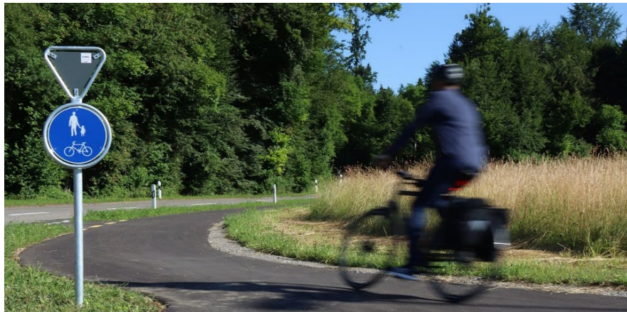
Rad- und Gehweg Uster-Freudwil, Neubau, Stadt Uster
