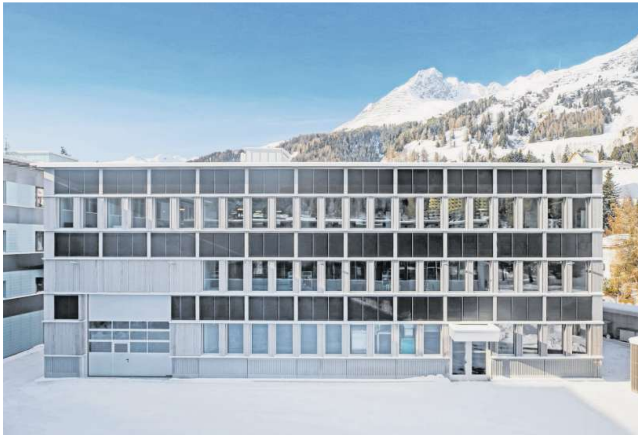
Wegen der grossen Schneemengen ist die Photovoltaikanlage in die Fassade des neuen Gebäudes integriert worden.
