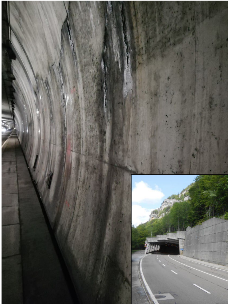
Tunnel de la Clusette:
